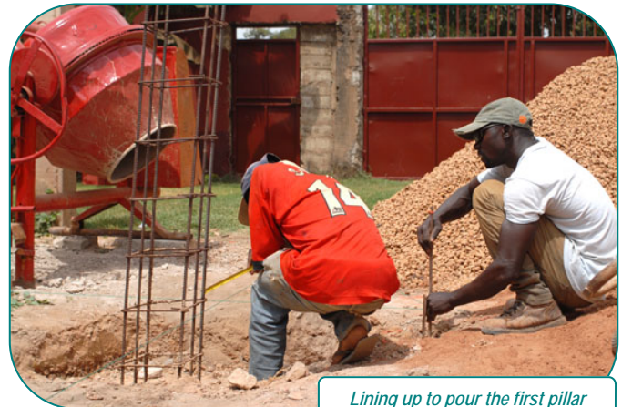
Lining up to pour the first pillar
